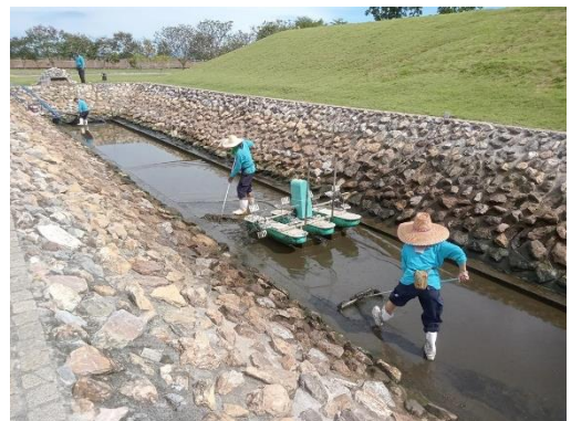
ภาพที่ 2-40 การล้างทำความสะอาดท่อระบายน้ำและ Recycle Pond
