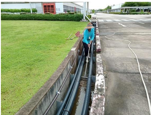
ภาพที่ 2-40 การล้างทำความสะอาดท่อระบายน้ำและ Recycle Pond
