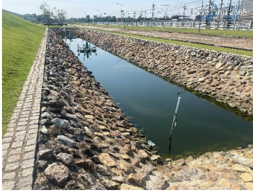
ภาพที่ 2-10 การติดตั้งอุปกรณ์หมุนเวียนน้ำในบ่อน้ำหมุนเวียน (Recycle Pond)
