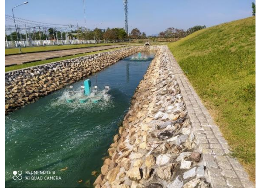
ภาพที่ 2-10 การติดตั้งอุปกรณ์หมุนเวียนน้ำในบ่อน้ำหมุนเวียน (Recycle Pond)
