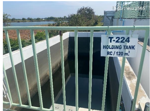
ภาพที่ 2-12 ถังพักน้ำทิ้ง (Holding Tank)
